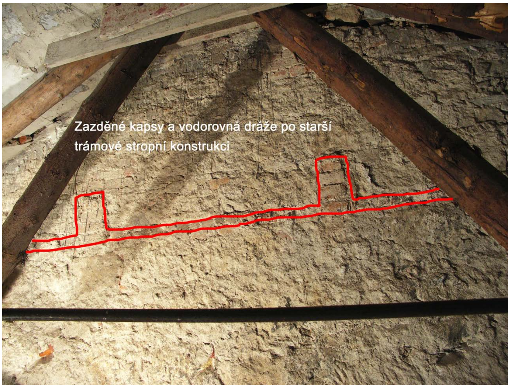
Česká Lípa, ulice Tržní, dům čp. 159. Interiér, 1. NP, místnost č. 13, západní stěna, detail stop po původní horizontální konstrukci, pohled od východu.
